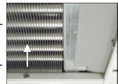
Reinigungsarbeiten an Türluftschleieranlagen mit einem **Elektroheizregister** bleiben auf das Gehäuse reduziert. Das Innere der Türluftschleieranlage ist gegebenenfalls von einem Fachmann (Elektriker) zu prüfen.
