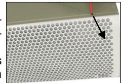
Bei der Wartung sollte je nach Schmutzanfall das **Warmwasserheizregister** (hinter dem Ansauggitter) mit einem Staubsauger und einem Heizkörperpinsel gereinigt werden.
